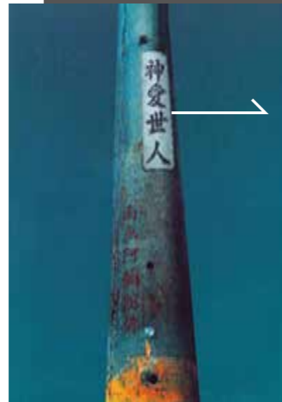
Taiwan années 80 : «Dieu nous aime» sur les poteaux électriques
